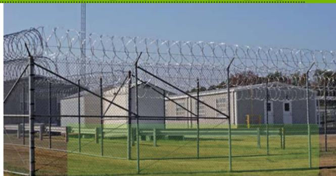
**Componenti TPSEM200.** Il sistema TPS™ meccanico, TPSEM200, utilizza un palo sensore. I fili spinati tesi vengono collegati all'interno del palo sensore a sensori Joystick. Il sensore TPS "Joystick" fornisce direttamente in morsettiera il contatto N.A. di allarme.
